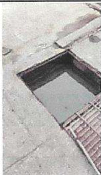
Foto 5: PATIO: Reparación de drenajes pluviales.
