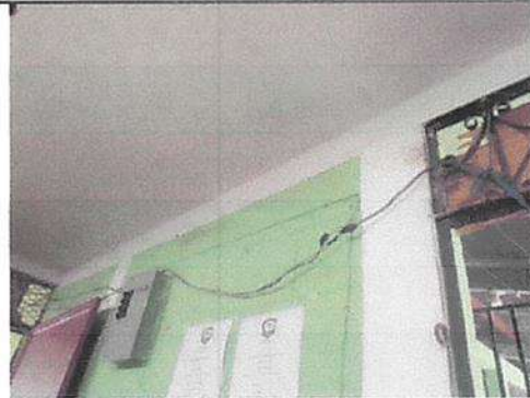
Foto 4: DIRECCION: Sustitución de sistemas eléctricos. Y pintura de interiores y exteriores.
