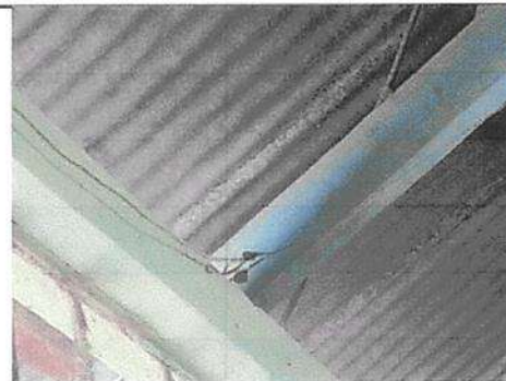
Foto 6: AULAS: Sustitución del sistema eléctrico.
