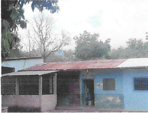
Foto 1: COCINA: Fabricación e instalación de estructura portante y suministro e instalación de lamina troquelada aluzinc calibre 26, montaje y desmontaje de techo existente. Y pintura paredes interior y exterior.
