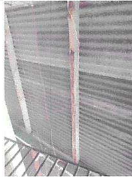
Foto 2: Instalación de sistema eléctrico.
